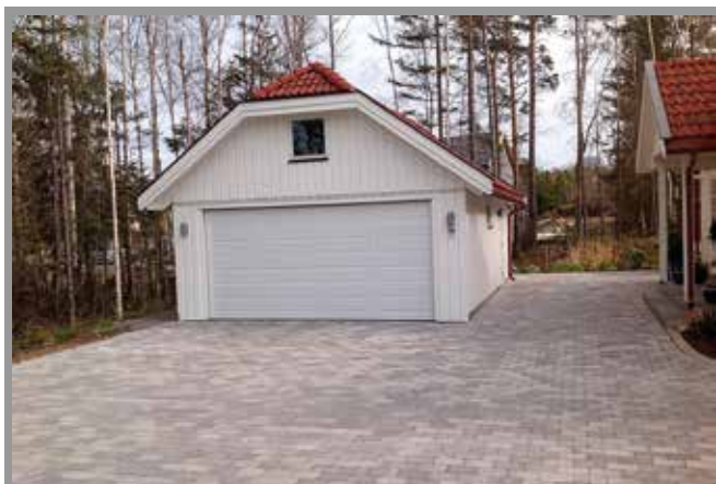
Garasje med halvvalm
